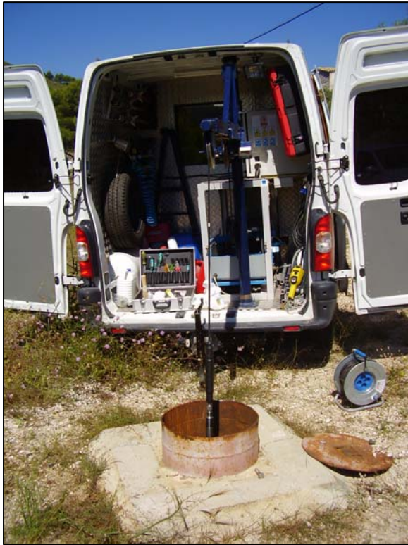
Fotografía 3: Detalle del brocal del sondeo.
