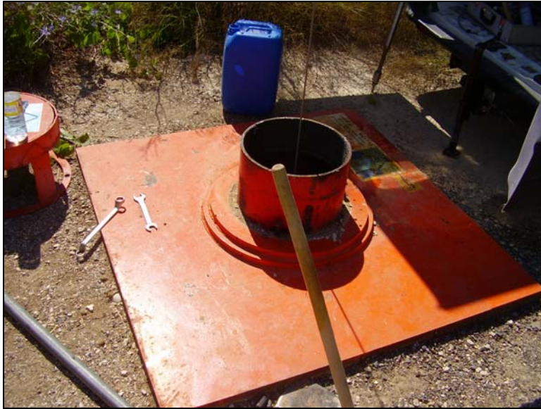
Fotografía 3: Detalle del brocal del sondeo.
